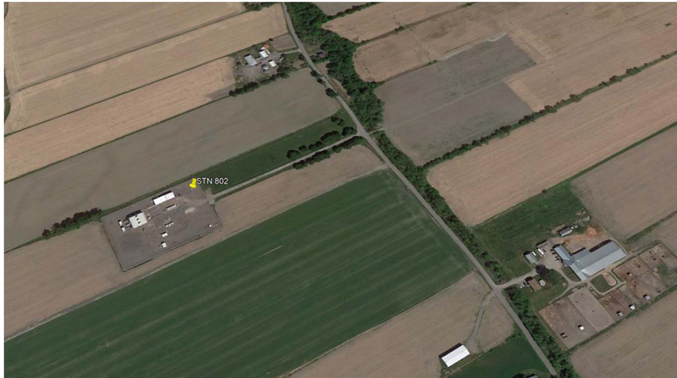
Exemple de la station de compression à Saint-Philippe au Québec
