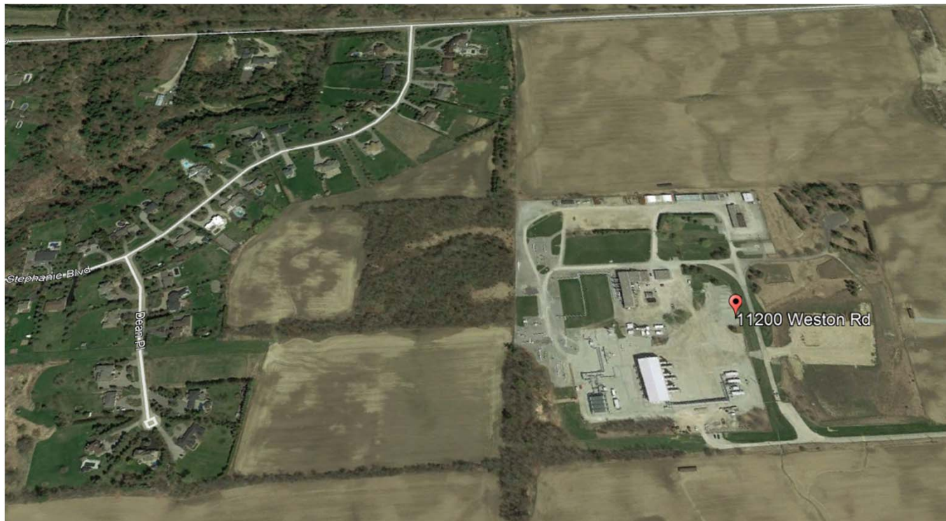
Exemple de la station de compression à Maple en Ontario
